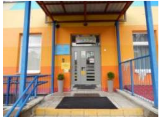
Противоскользящее покрытие на главном входе учреждения
